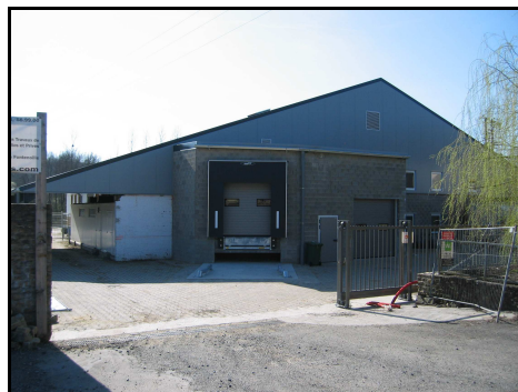
Abattoir de Virton en rénovation
