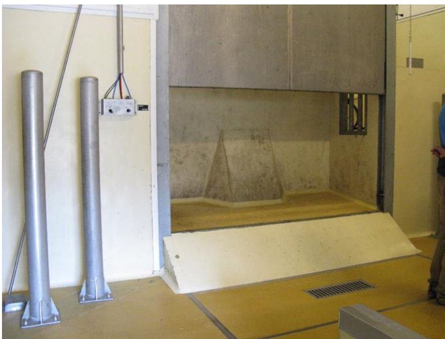
Abattoir de Virton, infrastructure pour l'étourdissement des bovins.
